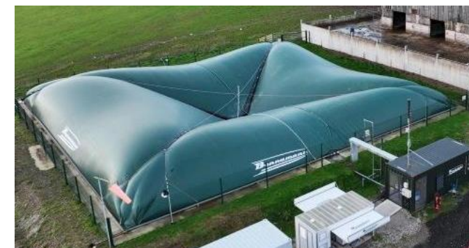
Bâche sur nouvelle lagune (collecte + stockage)
